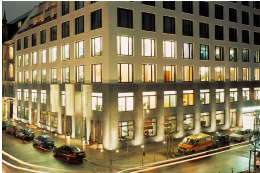
Immer nur Ärger mit der Grundstückvergabe. Landau Media an der Friedrichstraße
